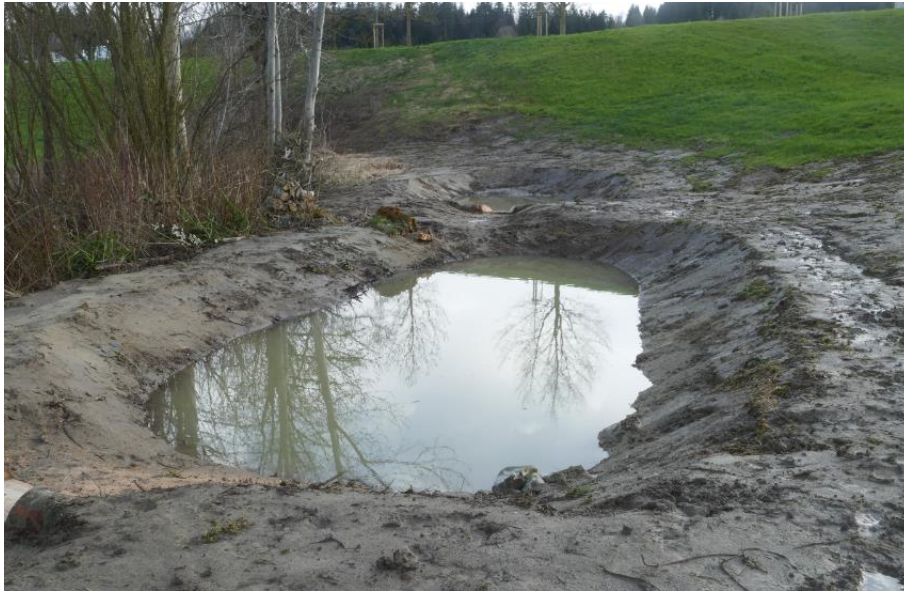
Der Aushub für den Weiher bei Lipperüti in Neuenkirch.
